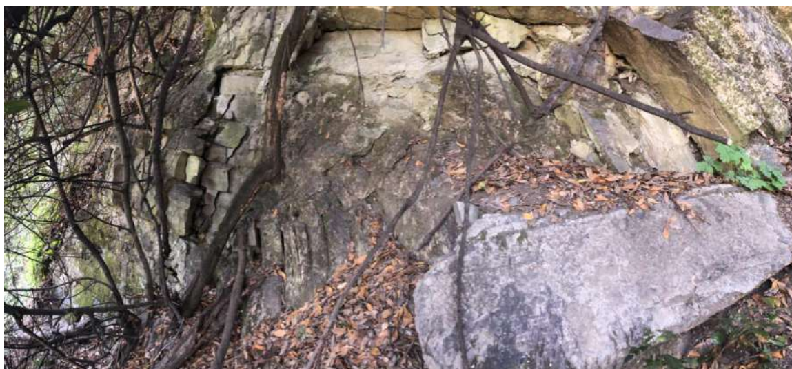
Area rilievo geomeccanico RGM1
