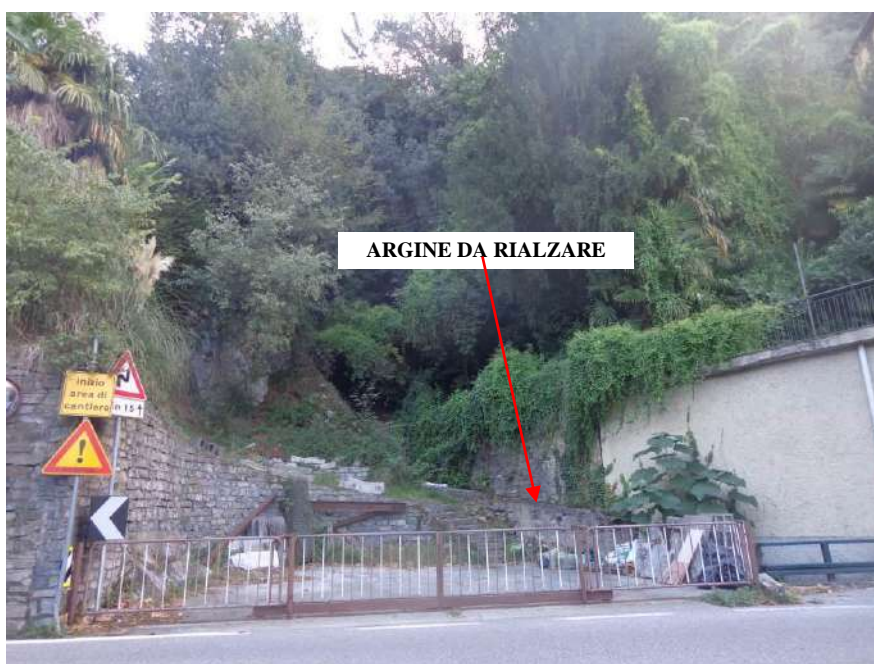
Tratto di torrente Colombaro ove realizzare interventi di risagomatura
